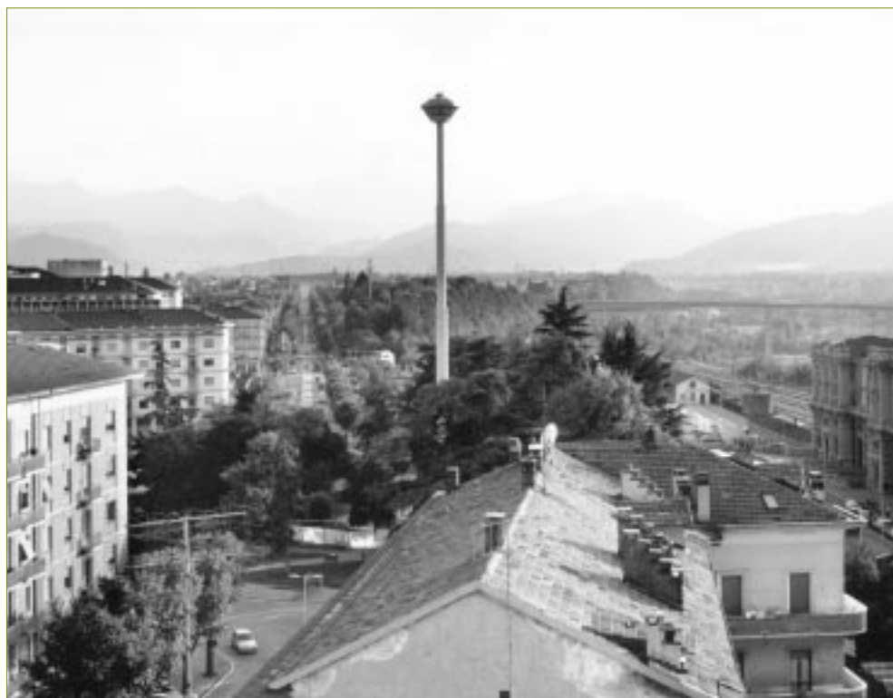
Il piazzale della stazione oggi, al termine del restauro del faro.
