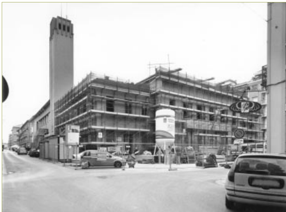
Il cantiere che sta trasformando l'ex Catasto Terreni nel Centro di Documentazione Territoriale. (Foto di Giorgio Olivero)
