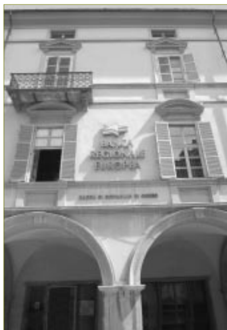
La sede di via Roma, "quartier generale" della banca e della Fondazione dal 1910.
