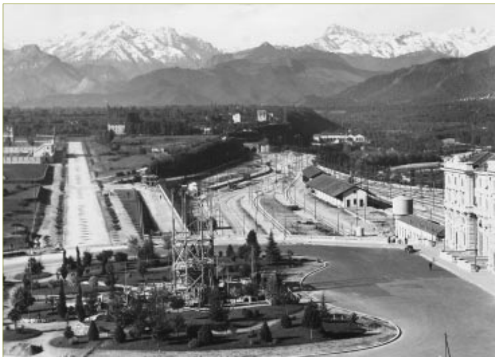
Il faro della stazione nuova in costruzione.
