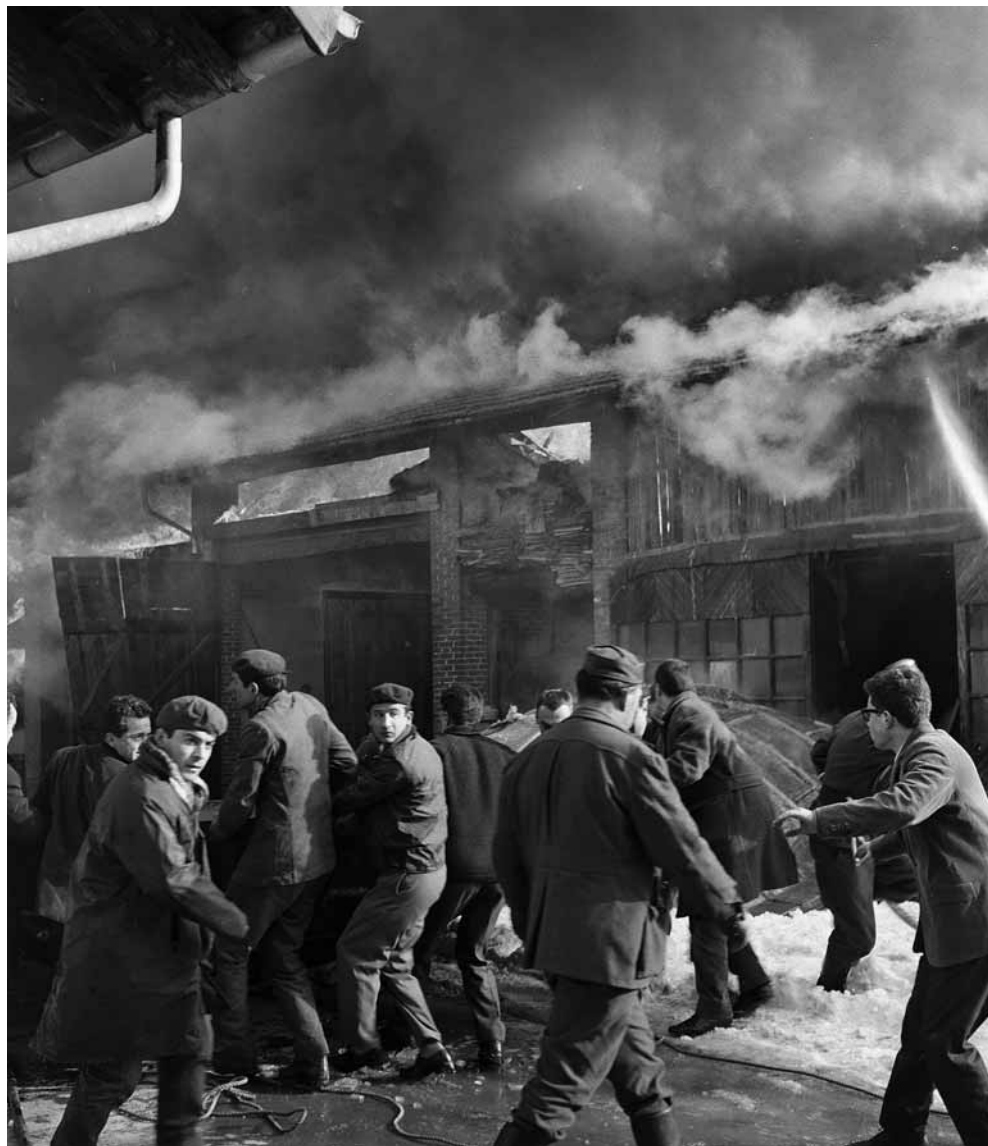
4 gennaio 1965 - Incendio, in via Negrelli, di due capannoni destinati alla lavorazione di materie sintetiche e della frutta (Foto di Paolo Bedino)
