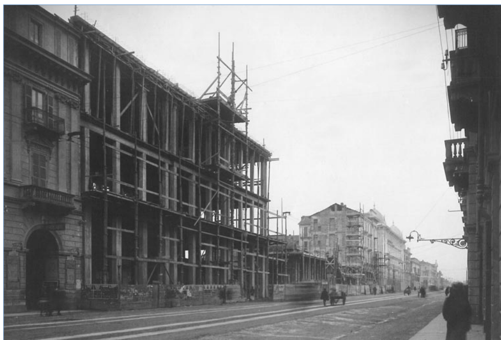
Palazzo della Banca d'Italia in costruzione, 1928 circa
