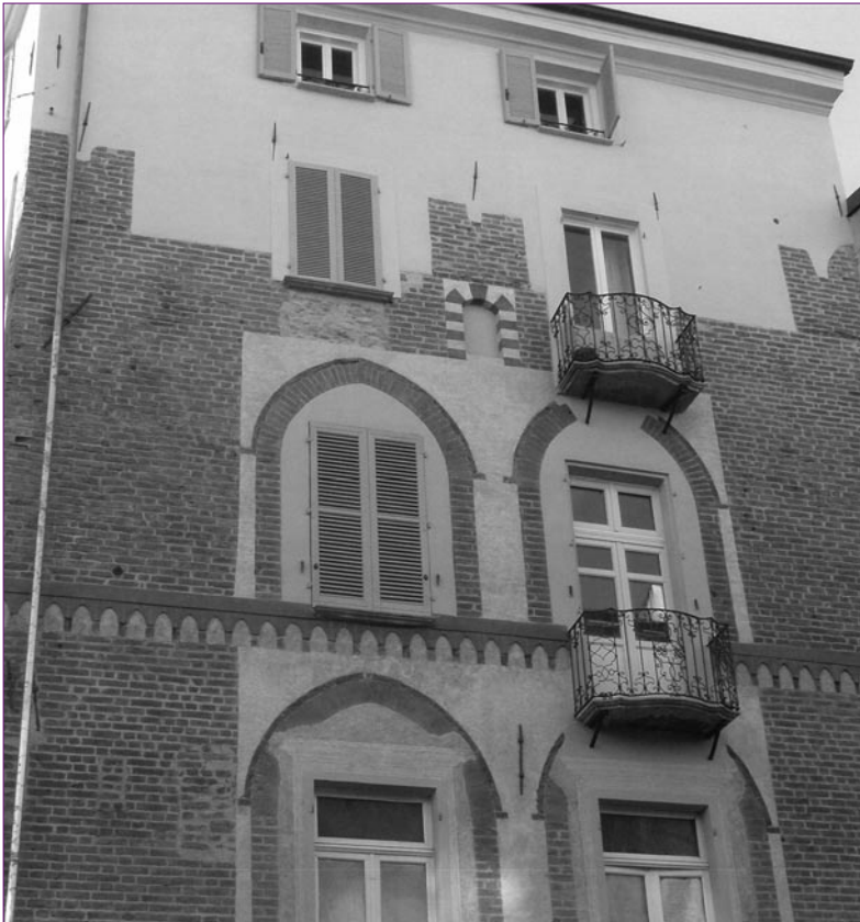
Il sorprendente tessuto gotico della facciata di casa Basso, via Roma 29
